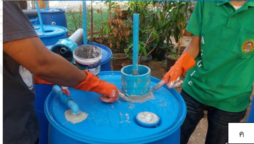
ภาพภาคผนวกที่ 3 การประกอบถัง ก) ทากาวซิลิโคนเพื่อป้องกันการรั่วของถังเก็บก๊าซ ข) ต่อท่อให้น้ำหมักออก ค) การใส่แกนทวนของหมัก
