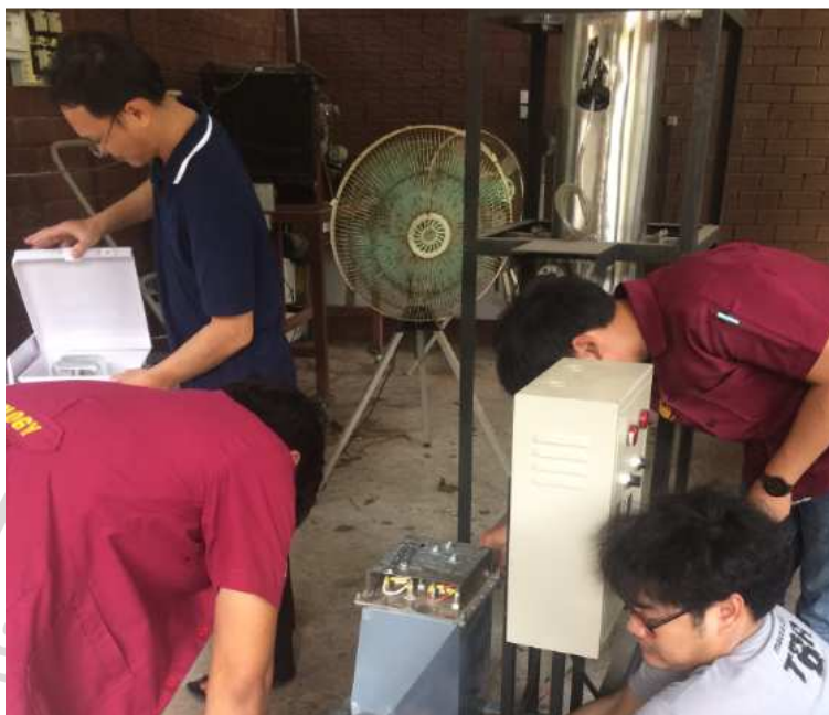
ภาพภาคผนวกที่ ก.9 การต่อชุดควบคุมไฟฟ้าเครื่องอบแห้งพ่นฝอย
