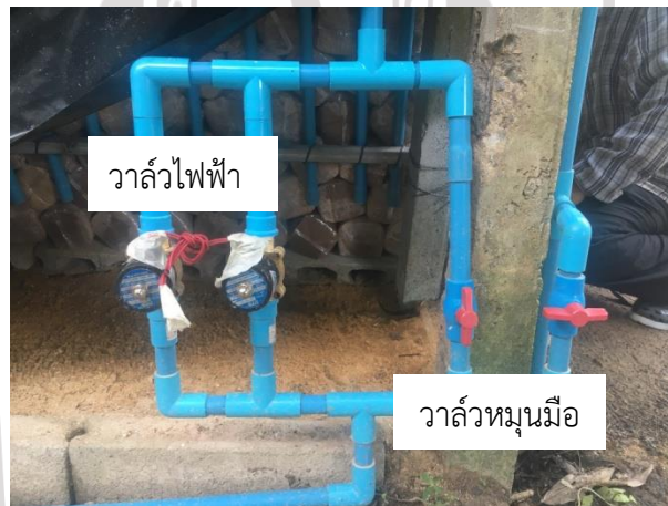
ภาพที่ 4.13 การติดตั้งวาล์วน้ำไฟฟ้า
