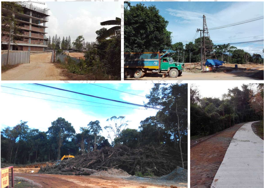
ภาพที่ 4.1 การก่อสร้างอาคารขนาดใหญ่ทางทิศเหนือ (บนซ้าย) และใต้ (บนขวา, ล่างซ้าย) ตลอดจนการสร้างถนนคอนกรีต (ล่างขวา) ระหว่างปี พ.ศ. 2557-2560
