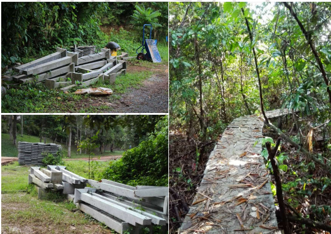
ภาพที่ 4.5 การก่อสร้างเส้นทางศึกษาธรรมชาติ (ช่วงปี พ.ศ. 2558) บริเวณทิศตะวันตกของป่าใกล้จุดสำรวจที่ 1
