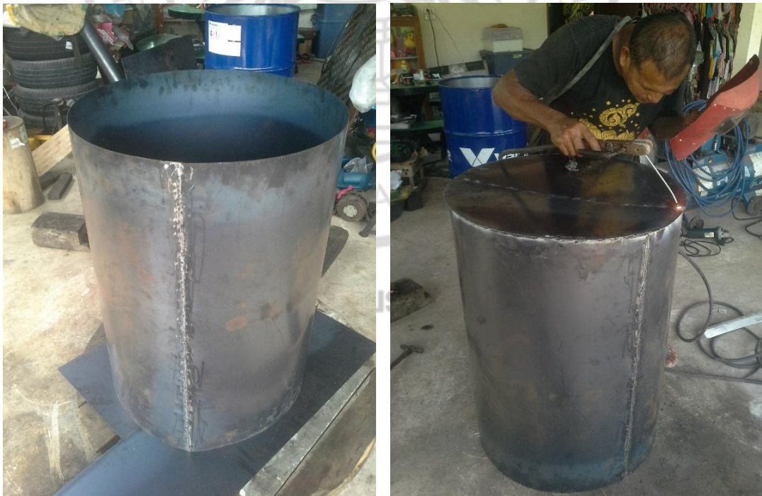
ภาพที่ 4.1 แสดงลักษณะการเชื่อมแผ่นเหล็กทรงกระบอกเป็นถังชั้นนอก
