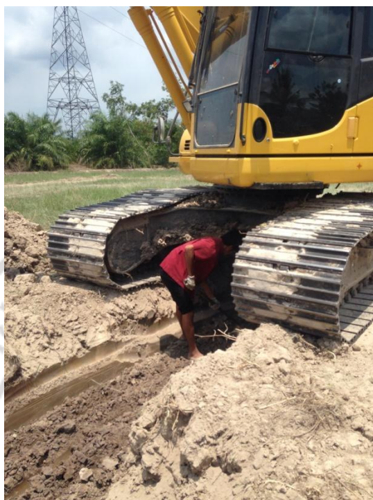
การเตรียมการทดสอบการรับกำลังแบกทาน บริเวณ วัดหนองสีงา อ.นายายอาม
