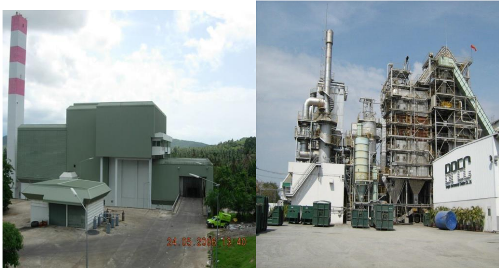
ภาพที่ 2.8 เตาเผาแบบ Mass burn ขนาดใหญ่
