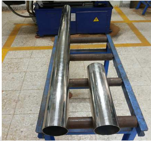
ภาพภาคผนวกที่ ก.23 การตัดท่อสแตนเลสสำหรับข้อต่อต่างๆ
