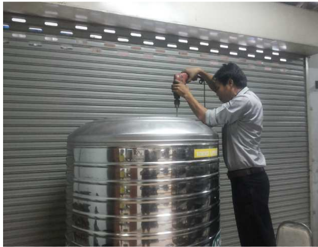
ภาพภาคผนวกที่ ก.17 การเจาะรูสร้างฝาครอบถังหมักแก๊สชีวภาพ
