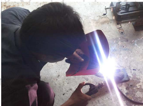
ภาพภาคผนวกที่ ก.31 การเชื่อมแผ่นเหล็กสำหรับเจาะยึดล้อเลื่อนโครงสร้าง
