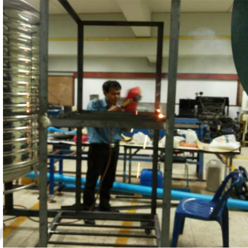
ภาพภาคผนวกที่ ก.32 เชื่อมโครงสร้างเพื่อรองรับระบบที่ออกแบบ
