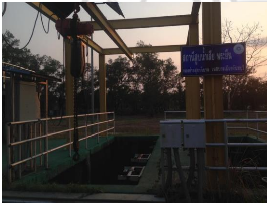
ภาพเครื่องขัดแยกมูลฝอยก่อนปล่อยน้ำเสียเข้าสู่ระบบบำบัด
