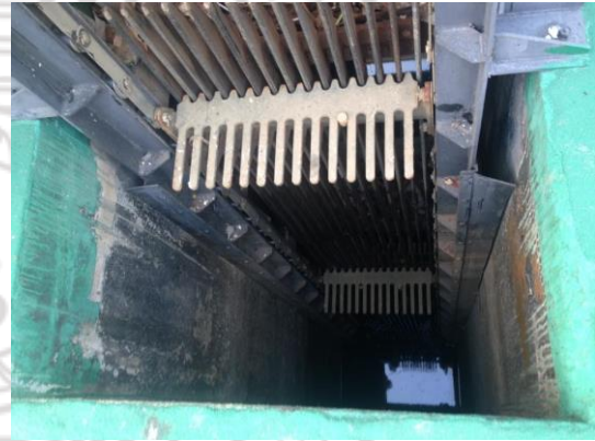
ภาพเครื่องขัดแยกมูลฝอยก่อนปล่อยน้ำเสียเข้าสู่ระบบบำบัด
