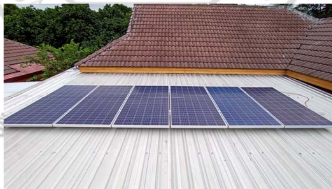
ภาพที่ 4.4 การติดตั้งแผงโซลาร์เซลล์บนหลังคาเมทัลชีต
