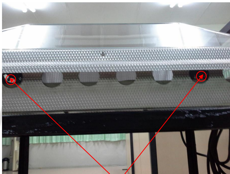
ติดตั้งพัดลมขนาดเล็ก
