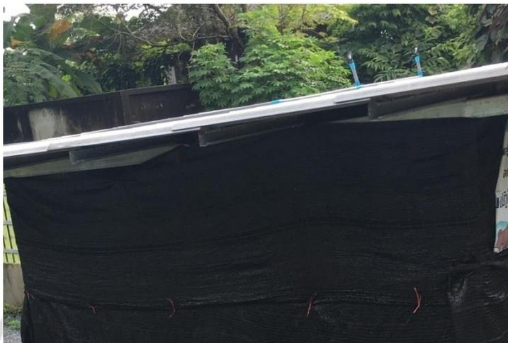
ภาพที่ 4.13 (ข) การติดตั้งสปริงเกอร์บนหลังคาโรงเรือนเพาะเห็ดของระบบฉีดพ่นละอองน้ำ
