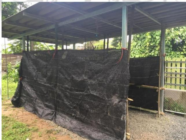
ภาพที่ 4.11 โครงสร้างของโรงเรือนเพาะเห็ดต้นแบบ
