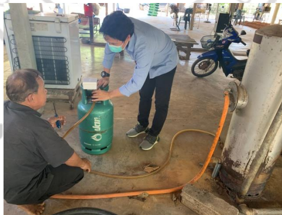
ภาพที่ 4.16 สาธิตการติดตั้งระบบเพื่อใช้งานจริง
