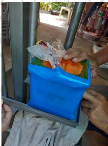
ภาพที่ 4.9 แสดงการจัดสร้างชุดรองรับแบตเตอรี่และการติดตั้งแบตเตอรี่
