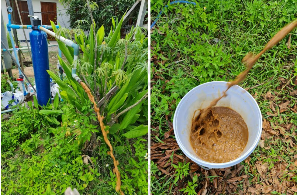
ภาพที่ ก.3 ลักษณะน้ำที่ออกมาขณะทำการล้างย้อน
