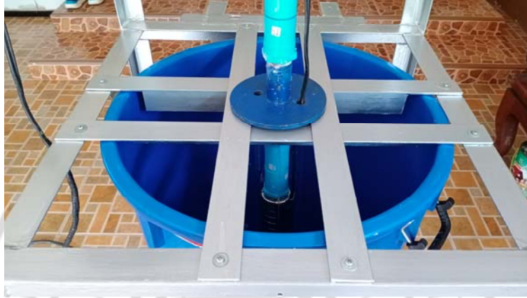
ภาพที่ 4.5 การติดตั้งเครื่องสูบน้ำบาดาลมอเตอร์ไฟฟ้ากระแสตรง
