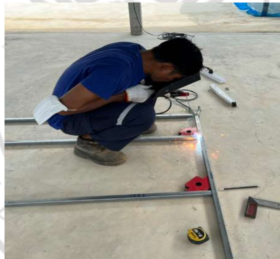
ภาพที่ ก2 การเชื่อมประกอบโครงสร้าง
