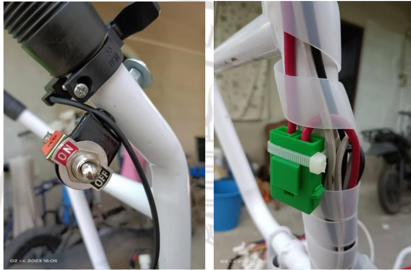
ภาพที่ 4.10 แสดงลักษณะการติดตั้งสวิตช์ และการติดตั้งชุดฟิวส์ตัดตอนอัตโนมัติ
